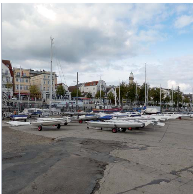
Abb. 18 | Steg- und Slipanlage der Landessportschule; im Hintergrund die Bebauung an der Straße Am Strom und der Leuchtturm Warnemünde
