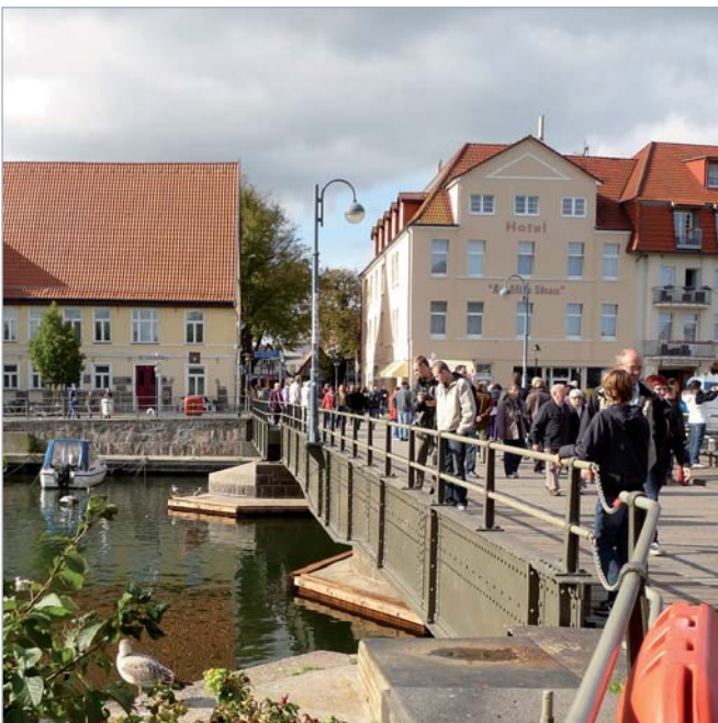
Abb. 12 | Blick über die Drehbrücke in Richtung Osten
