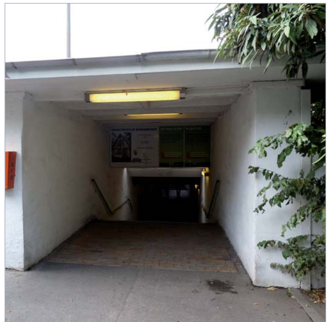
Abb. 13 | Östlicher Eingang des nicht barrierefreien Fußgängertunnels im Bereich des Bahnhofs Warnemünde
