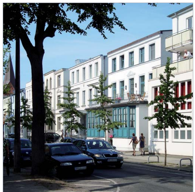
Abb. 7 | Wohnbebauung in der Fritz-Reuter-Straße - südlich des Kirchenplatzes
